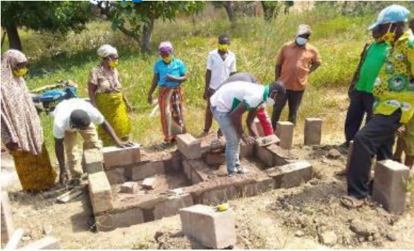
Une latrine en construction
